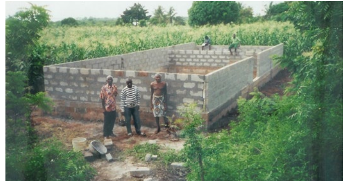
Erstes Foto vom Baubeginn
